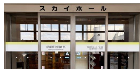
仮設図書館出入口
